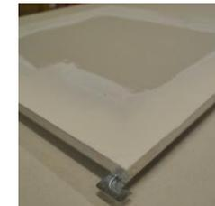
5. Una vez realizado el tratamiento en la Tapa de Inspección, marque el corte en el cielorraso utilizando el interior del marco, sumando 5mm aprox. en todo el perímetro.
